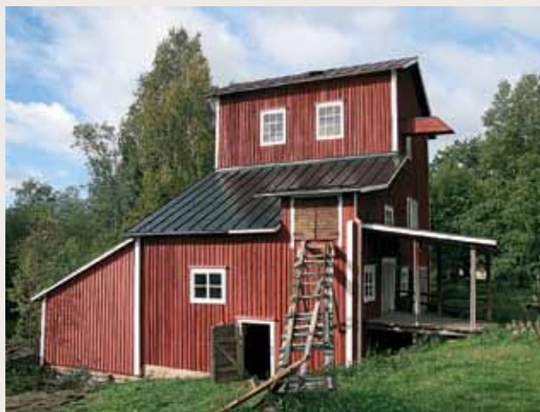
Långforsin mylly maalausten jälkeen. / Långfors kvarn efter målningen. Kuva/bild: Kaj Höglund
